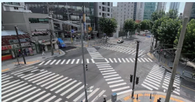
대각선 횡단보도 설치
