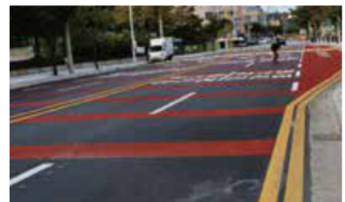
부영 1~5차 네거리 횡단보도 도로포장
