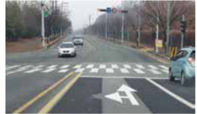
사동 부영 5차 방향 좌회전 신호등 설치
