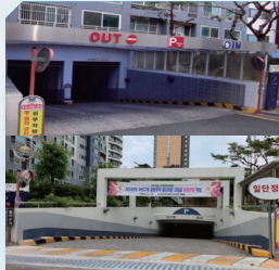
지하주차장 입구 트레치(배수로) 설치 (수성그린타운아파트)
