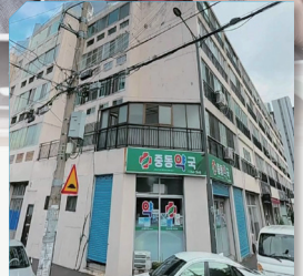
상가 수돗물 공급 저하 문제 해결 (서울중동아파트 내)
