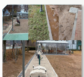
배수 정비 및 포장 공사 (수성못 상화동산 내)
