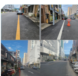
불필요 주차선 제거 (청수로24길 호반써밋수성아파트 인근 도로)
