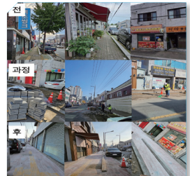
노후화 인도블럭 전면 교체 (들안로48길 일대)
