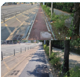
자전거길 보수 공사 (수성동일하이빌 레이크시티아파트 앞 자전거 도로)
