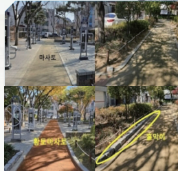
산책로 정비 및 흙막이 설치 (상록수어린이공원 내)
