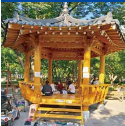
월명공원 내 한옥정자 설치 추진
