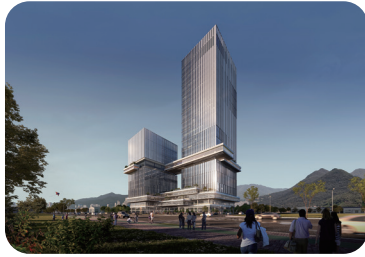
부산시 제2청사 설계완료 공사 착수
