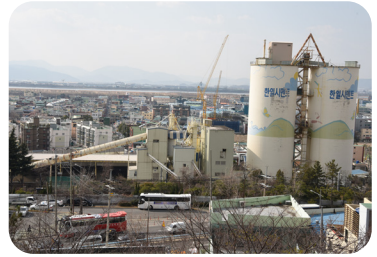
덕포 한일시멘트공장 운영중단, 철거착수
