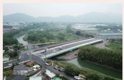
교량교 재가설 공사
