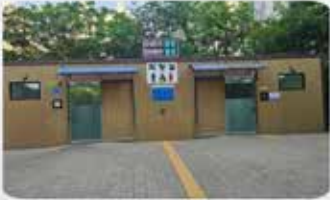
주엽공원 화장실 교체 완료
