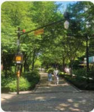
오마초등학교 후문 CCTV 설치 완료
