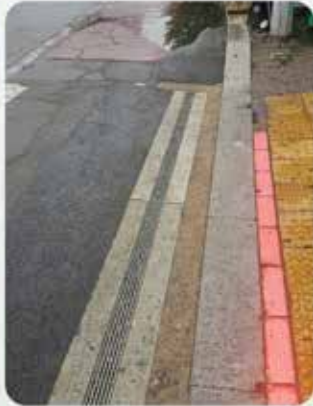
주엽역 버스정류장 배수로 작업 완료
