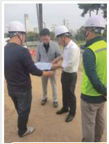
정체구간 확장공사 현장점검
