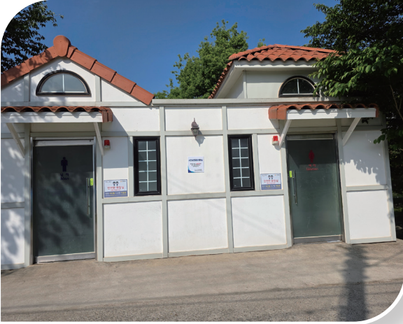
서면 우체국 옆, 서천 수변공원 내 화장실 설치
