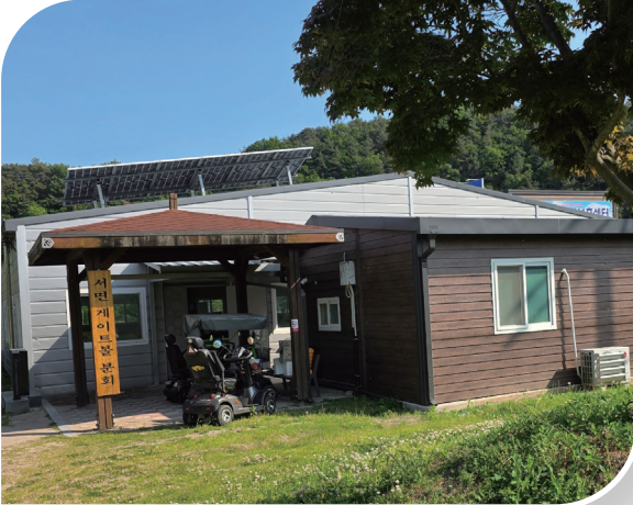
서면 실내 게이트볼 경기장 설치
