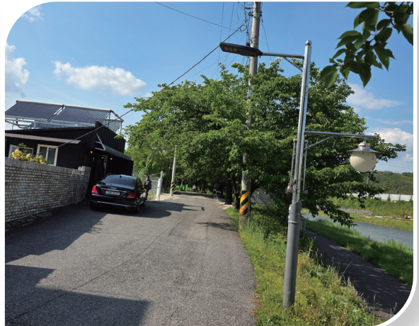
서면우체국~수변공원 간 보안등 설치공사
