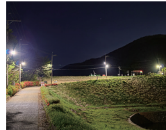
시명골 저수지 가는 길 조명 설치
