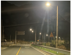
주남교~용암마을 가로등 설치
