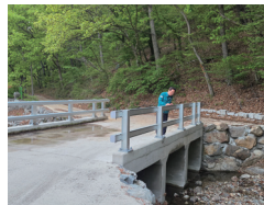
탐골저수지 앞 마을안길 교량 재가설
