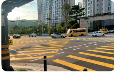
산동 인덕초등학교앞 대각선 횡단보도 설치
