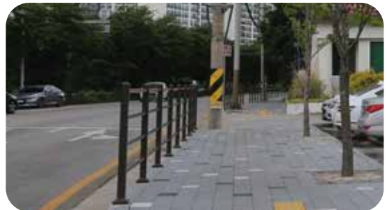
효자3동 광진라미안 옆 안전휀스 설치
