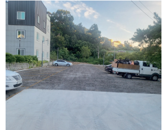
도량2동 3주공 뒤 행복주차장 설치
