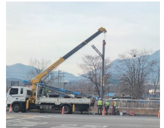
조일월드빌 앞 신호등 설치
