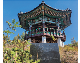
도지사 정상 구미정 보수 공사
