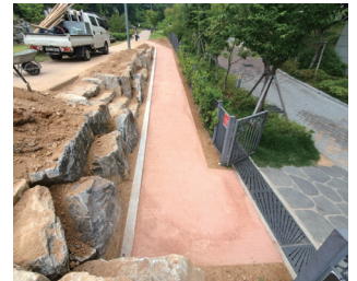
산림공원 산책로(유모차 통행) 보수 공사
