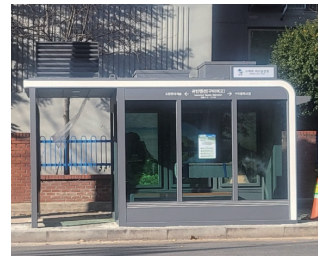
귀민맨션 앞 스마트승강장 설치(3호)
