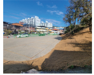
명지유치원 옆 폐가 철거 및 행복주차장 조성
