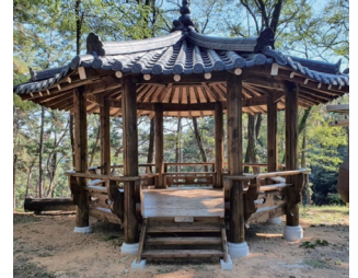
산림공원정상 파고라 정자 설치
