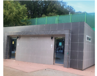
소로골원 화장실 및 먼지떨이 설치
