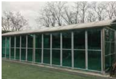
천풍족구장(휴게시설, 관람석, 웬스 추가설치 등)
