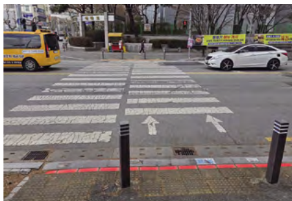
레이안아파트 사거리 바닥신호등 설치
