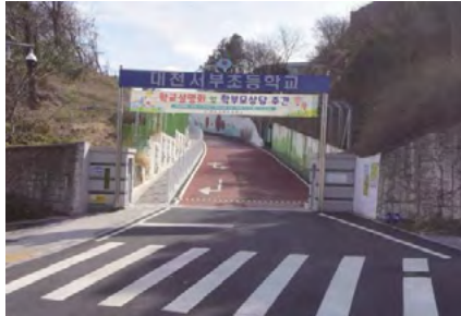
서부초 정문(진입로) 확장공사
