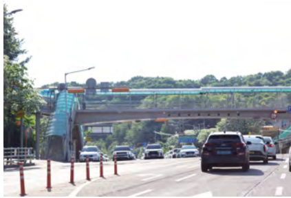
서부초 보도육교 비가림막 설치
