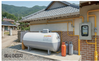
에너지 복지 실현, LPG 시설 설치 지원(무실마을)
