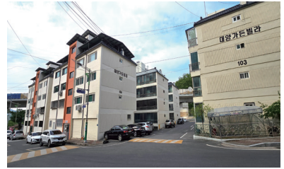
소규모 공동주택 보수 지원 (마잠 대양빌라 외 11개소)
