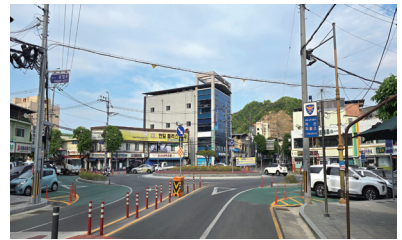
용파사거리 회전교차로 설치
