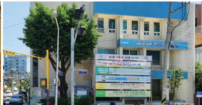
행정복지센터 엘리베이터 설치, 강당·외벽·화장실 공사
