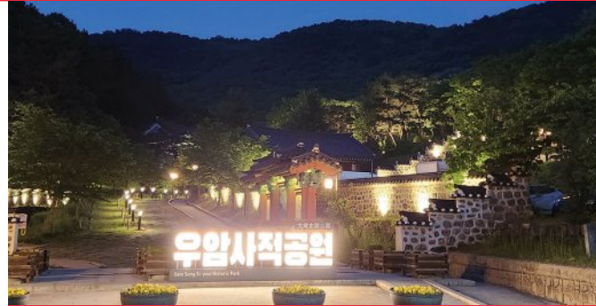
우암사적공원 야간 경관 조명 설치
