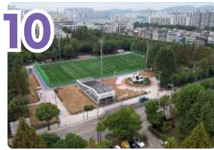
10 신트리공원 지하주차장 준공
