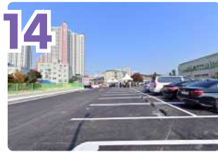
14 심정동 변전소 및 농업기술센터 부지 2곳 공영주차장 조성
