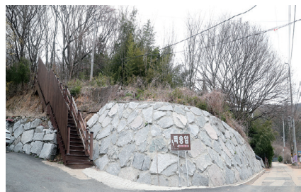
▲기린봉 등산로 축대 시공
