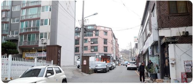
▲백동길 언덕 열선공사(미끄럼방지)
