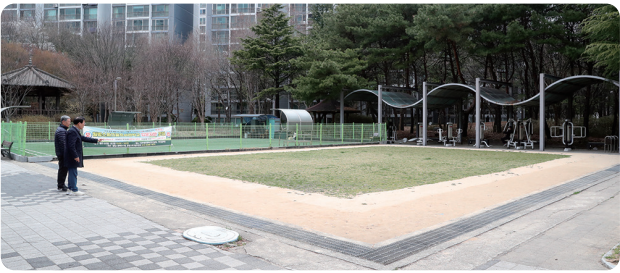
▲아람길공원 맨발걷기공간 확대공사 추진
