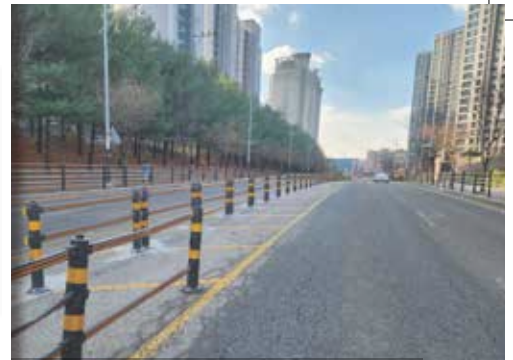
아이파크 1차 아파트 후문 중앙분리대 설치
