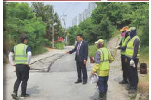
구좌리 칼국수 앞 도로 보수
