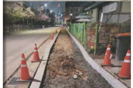
우리병원 구간 보도 설치
