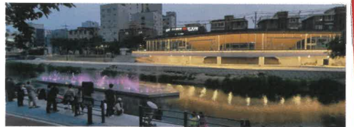
우이천 문화예술거리 조성-우이천 재간정 전경
