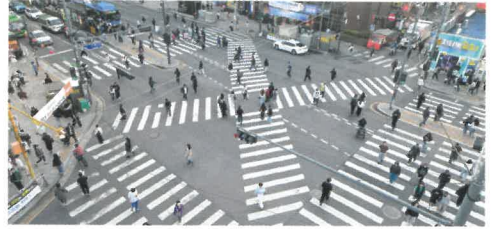
수유역 대각선횡단보도 설치 완료
