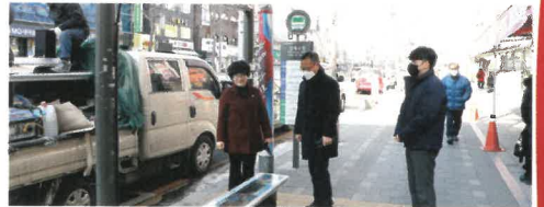
버스정류장 온열의자 설치
