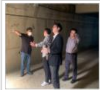
인창 유수지 주차장 조성 현장
