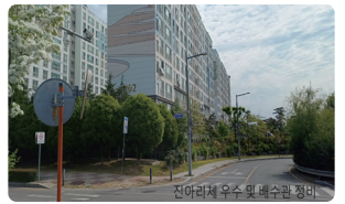
진아리채 우수 및 배수관 정비
