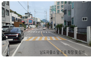
남도파출소 앞 도로 확장 및 정비
