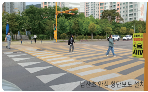
남산초 안전 횡단보도 설치
