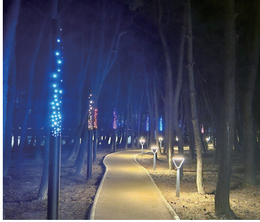
신호공원 및 신호해안 방재림 경관조명 설치
