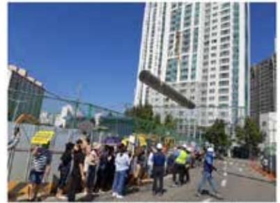
▲ 낙민동 주민들, 대심도 비상탈출구 공사업장에서 내방 통행차량 시설 시설을 노후화 시키는 등
