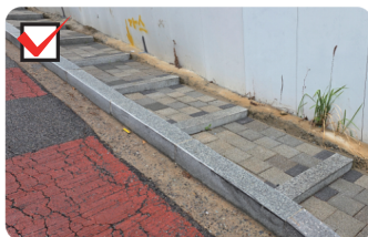
· 중동 오르막길(삼중로27번길) 수풀 제거 및 계단 설치 민원 처리 완료
