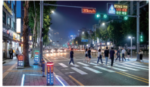
야간 LED 보행안전시설 설치
