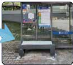
냉·온열의자 설치 후
