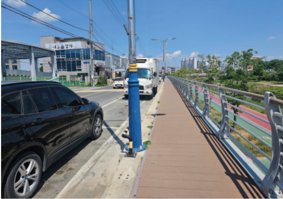
■ 조산천변 도로확장 및 보도교 설치
