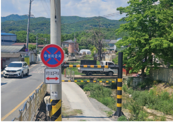
■ 남하리 소하천 정비공사 (마을진입로 확장 및 하천정비)
