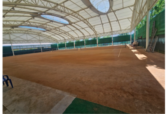
■ 하양생활체육공원 내 "돔" 정구장 건설
