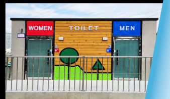
광려천 산책로 공중화장실 설치
