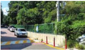
통학로 안전펜스 설치
