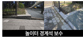
놀이터 경계석 보수
