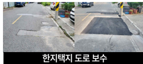
한지택지 도로 보수
