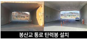
봉산교 통로 탄력봉 설치
