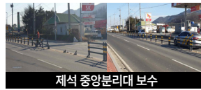
제석 중앙분리대 보수
