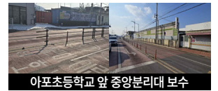
아포초등학교 앞 중앙분리대 보수
