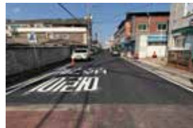
용산약국 남산초 아스콘 포장공사
