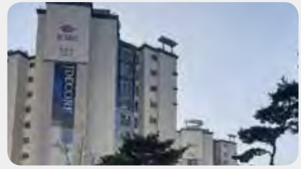
장동 에코르아파트 화물차고지 건설 중단
