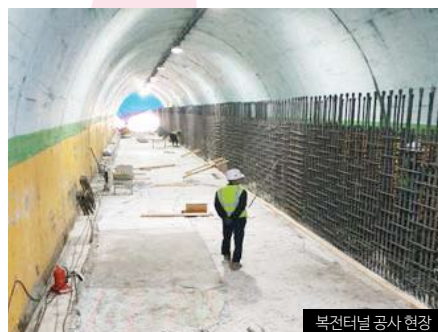
복전터널 공사 현장
