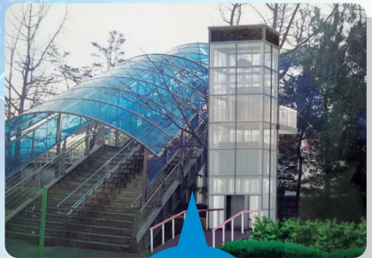
청량리역 임시보도육교 엘리베이터 설치 지원
